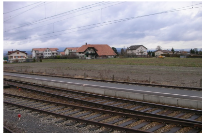
Voies aux abords de la gare de Sugiez
