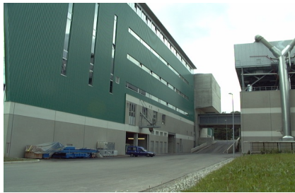
Lieu d'incinération des boues (droite)
