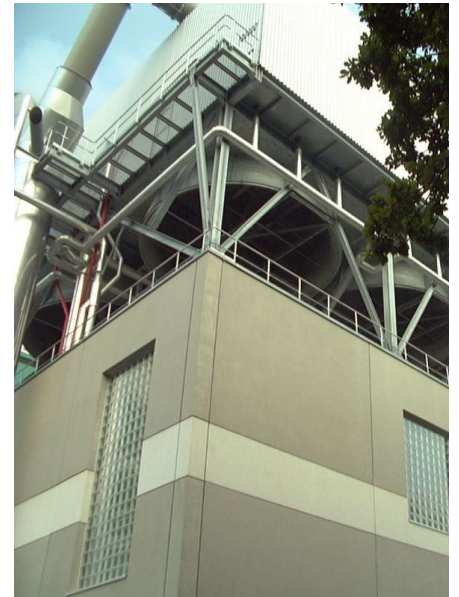
Turbine à vapeur
