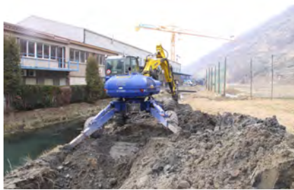
Bauarbeiten entlang des Kanals
