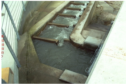
Wassereinlauf und Ausstiegsbecken
