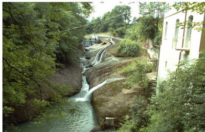
Übersicht der Fischtreppe - Kraftwerk
